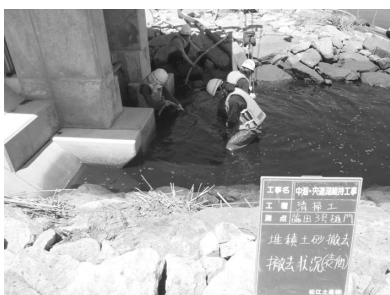
写真 2 堆砂撤去状況
