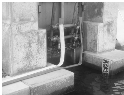
写真 4 ノズル設置状況
