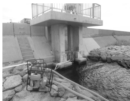
写真 3 実験 1 設置状況
