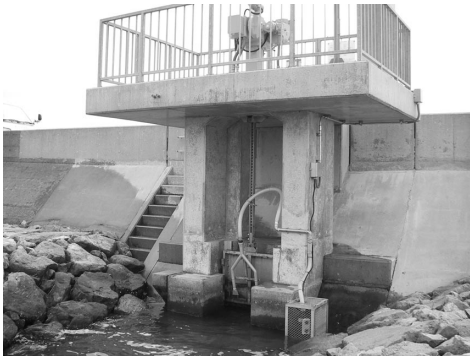
写真 5 除砂ポンプ全景
