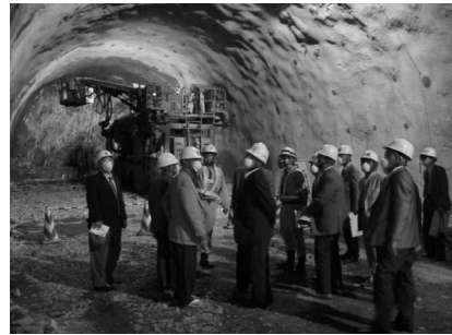
写真 2 トンネル構内で掘削(切羽)状況を視察
