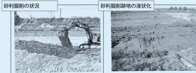
新潟県中越地震災害調査委員会報告書、公益社団法人地盤工学会、p127, 128, 2007.5より抜粋 砂利採取跡地の液状化被害
