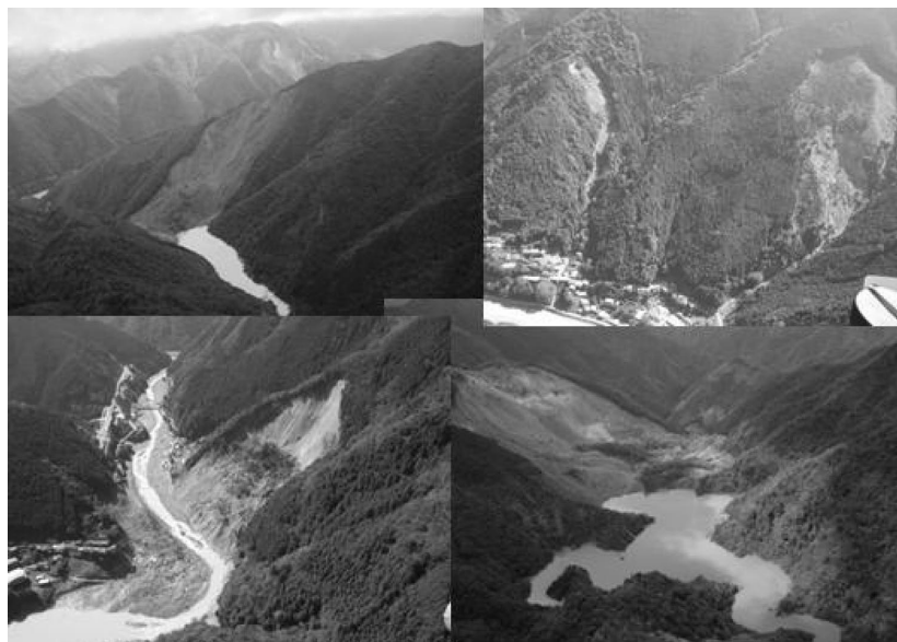
写真—1 台風12号による紀伊半島の崩壊状況
