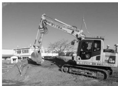
写真 2 施工性検証試験状況①
