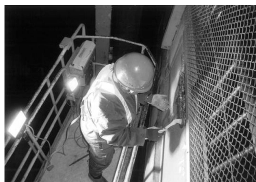
写真—4 コンクリート叩き落とし状況
