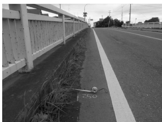
写真—2 清掃前状況
