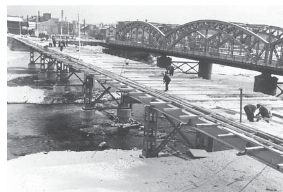
写真三 豊平橋仮橋架設工事（昭和39年12月）
