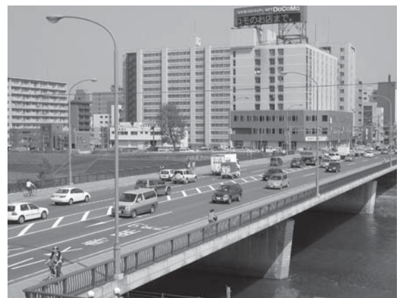
写真一 昭和41年に完成した現在の豊平橋
