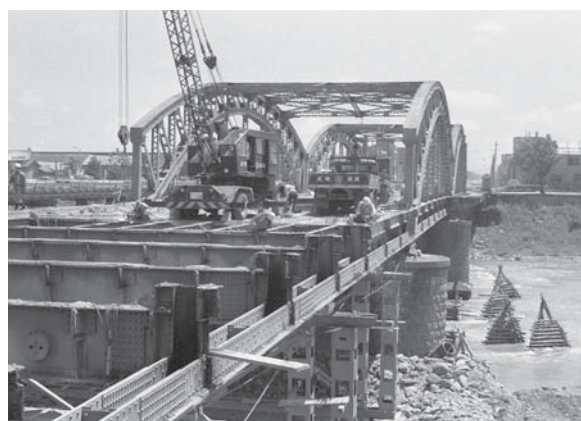
写真一 建設中の三連アーチ橋
