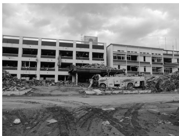
壊滅的な被害を受けた陸前高田市役所
