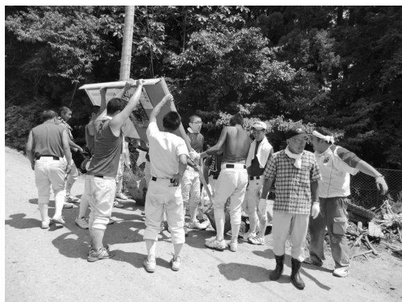
行政ばかりに頼らず、地元建設業者、自治会、高校生らと共に掲示板を製作・設置
