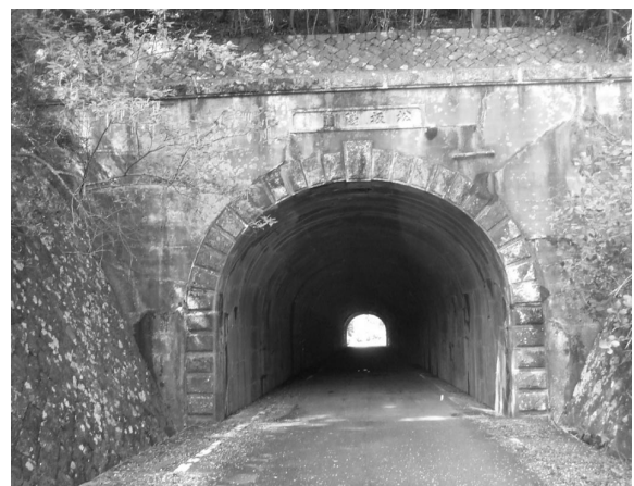
写真 1 松坂隧道（徳島側）
