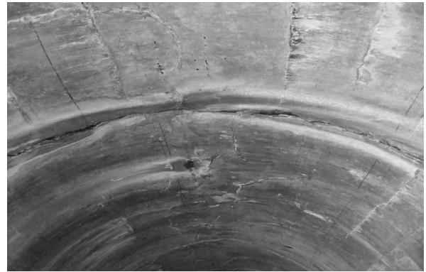
写真 5 トンネル内コンクリート状況
