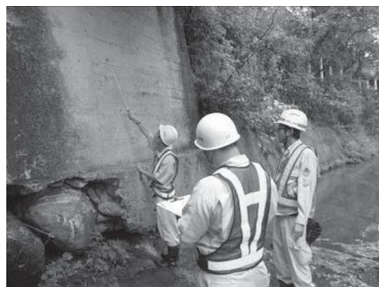
写真—6 地元の橋梁の異常や損傷を調査
