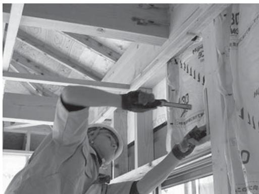
写真一3 断熱シートの貼付作業を行う生徒 (真岡工業高校)
