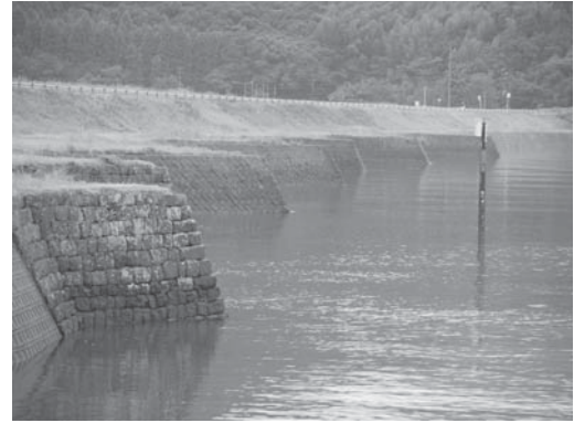
写真二 長崎堤防 上流側からの写真 (鹿児島大学理工学研究科 二宮公紀)
