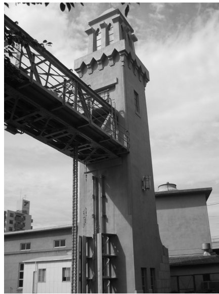
写真 2 塔の頂上部分
