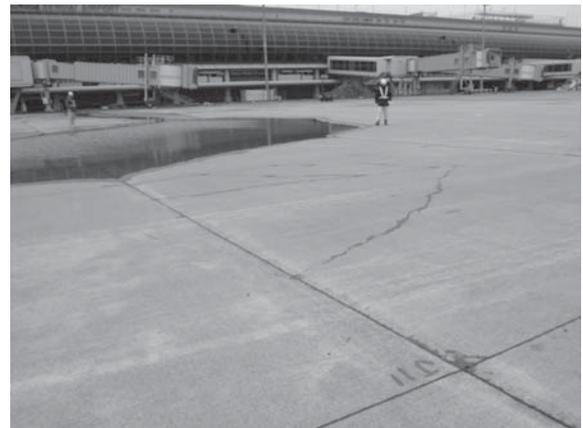
写真一4 エプロン沈下状況 (沈下による水たまりおよび沈下部周辺のひび割れ)
