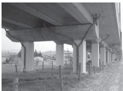
写真一八 鋼板巻き耐震補強箇所の状況
