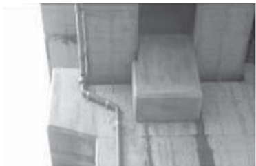
写真一六 RCサイドブロックの損傷と復旧
