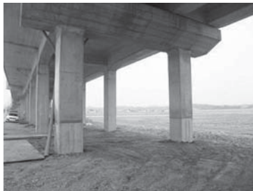
写真—1 高架橋柱の損傷と復旧
