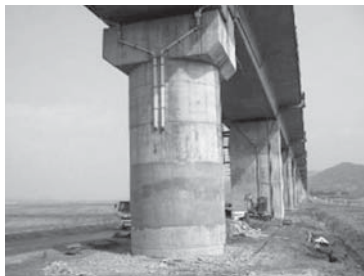
写真—2 橋脚の損傷と復旧
