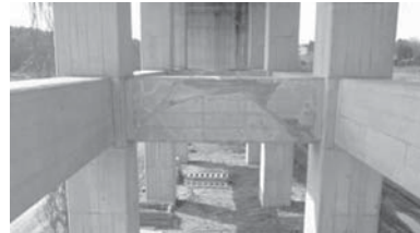
写真—3 高架橋中層梁の損傷と復旧
