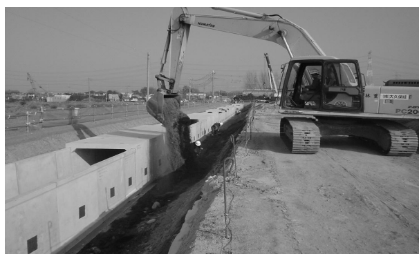
写真-1 はねつけ（投入）作業状況
