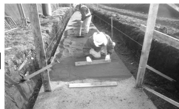
写真-4 敷モルタル
