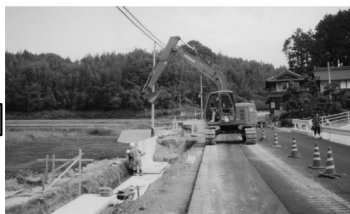
写真-5 プレキャスト擁壁据付
