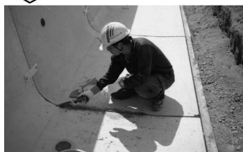
写真-7 目地モルタル
