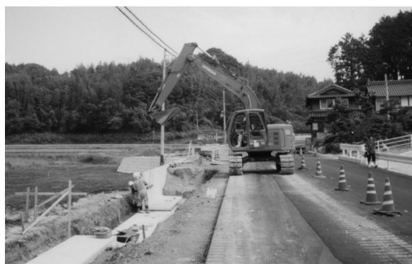
写真-10 バックホウ(クレーン機能付き)による施工
