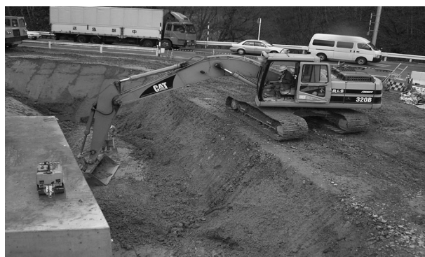
写真-2 敷均し作業状況
