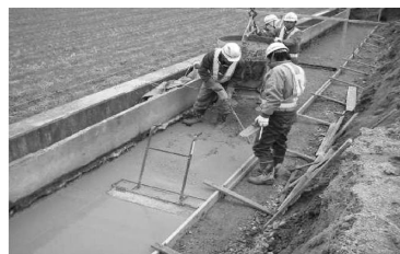
写真-3 均しコンクリート
