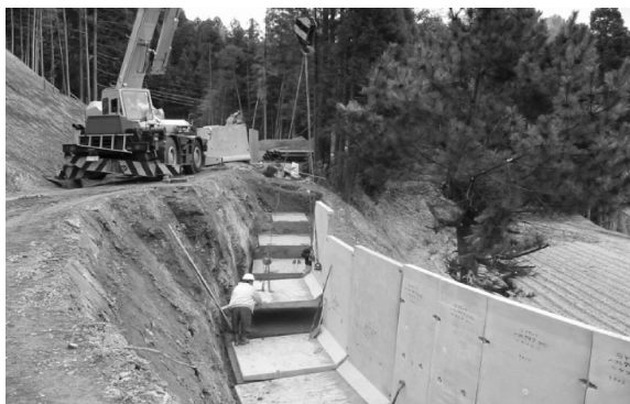
写真-11 ラフテレーンクレーンによる施工
