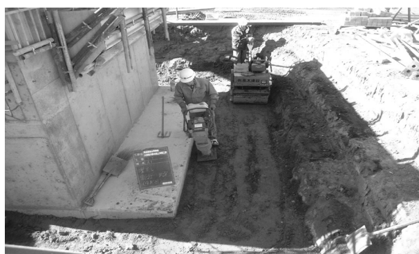
写真-3 締固め作業状況
