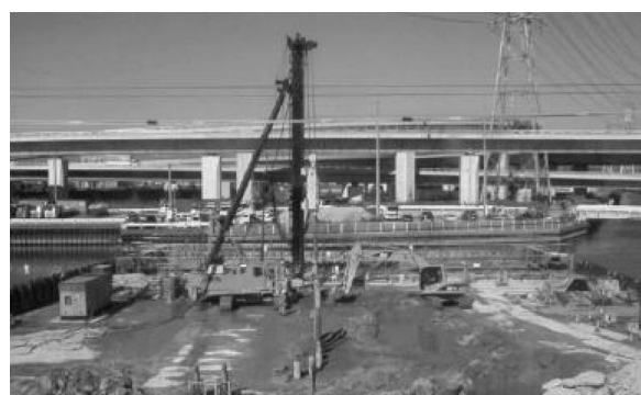
写真－2 三点支持式施工機による施工
