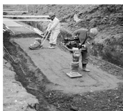
写真-2 基礎材設置
