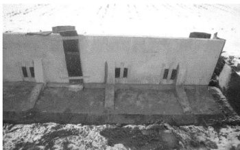
写真-8 排水材設置
