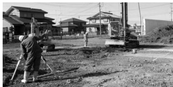
写真－1 小型施工機による施工
