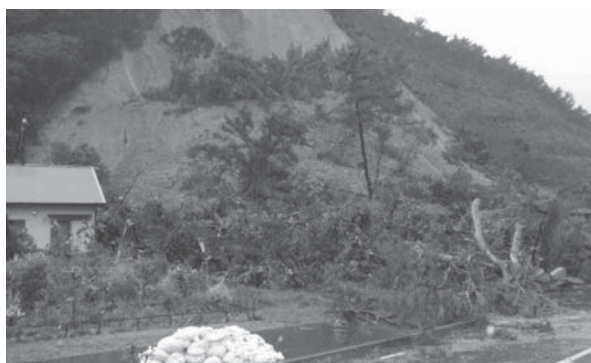
写真—7 龍郷町浦 土砂崩れにより、役場近くの国道58号線が通行止め
