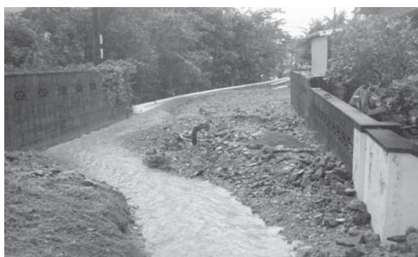
写真—9 大和村湯湾釜 生活道路に土砂が流入
