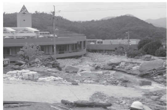
写真-2 土石流に襲われた老人ホーム (上田南川)
