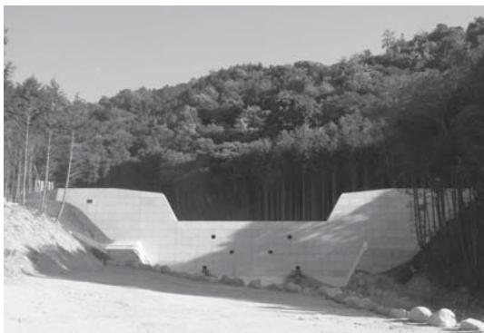
写真一7 上田南川砂防堰堤完成状況 (堤高11m, 堤長89m, 体積3,834m 3 )
