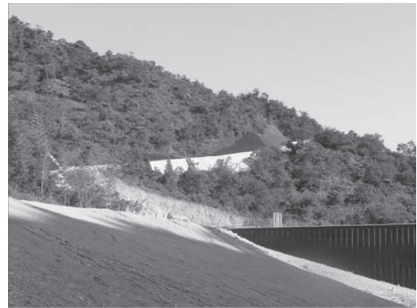
写真一8 直轄特定緊急砂防事業で整備した工事用道路（剣川）
