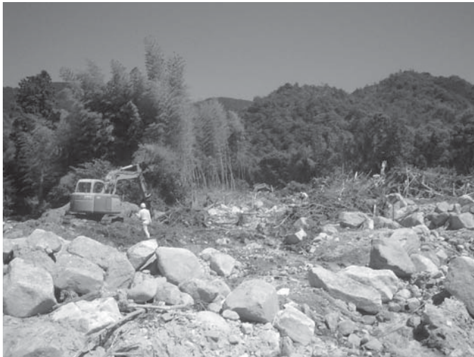
写真—4 進入路工事着手時の状況（上田南川）
