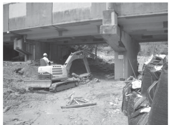
写真—5 新幹線高架下での作業（素川）
