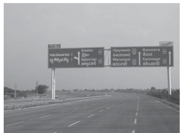
写真—1 ハイデラバード外環道路
