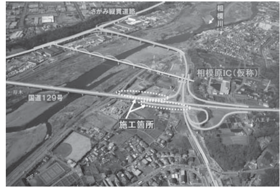
写真—1 現場状況写真
