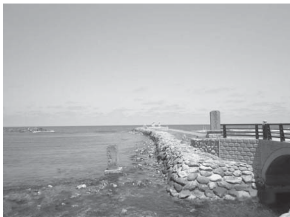
写真—1 東堤（手前は菊姫橋）
