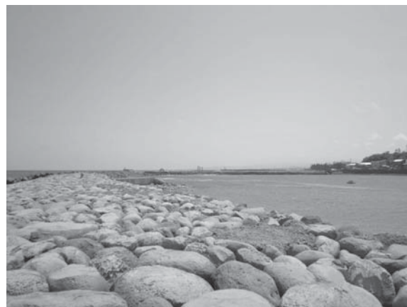
写真—2 西堤から東堤を望む
