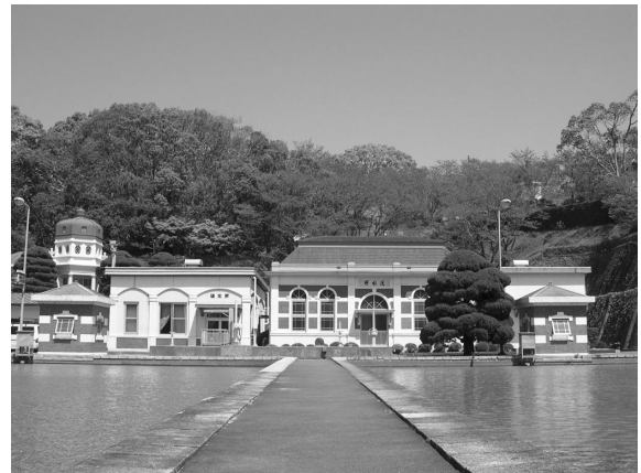
写真 2 旭浄水場（更新工事前）②
