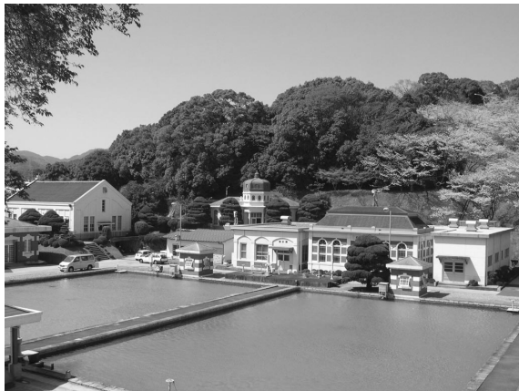
写真 1 旭浄水場（更新工事前）①
