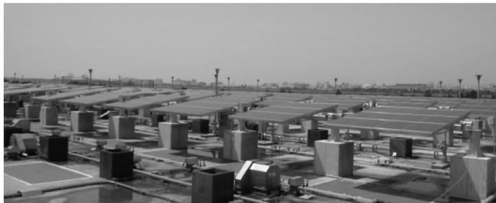
写真 3 下水処理場上部の太陽光発電施設（東京都）
