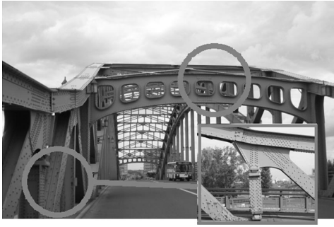
写真 1 ロッキングコラム，橋門構
