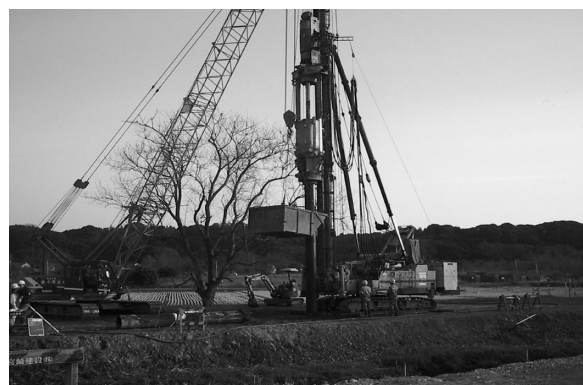
写真—1 施工全景
