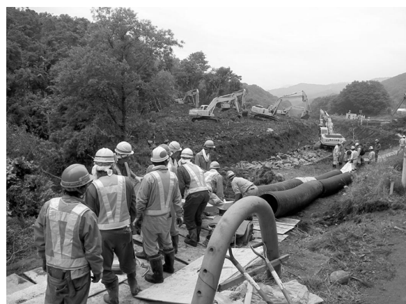
写真-3 天然ダムからの排水ポンプの設置作業
