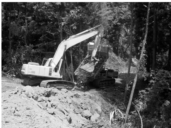
写真－２ 市野々原に重機を搬入するための迂回路の建設工事
