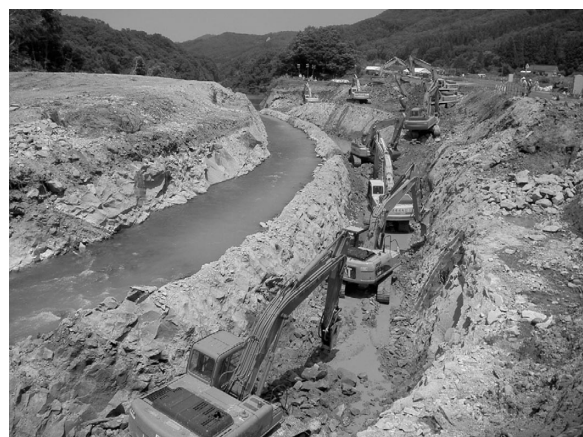
写真-4 市野々原地区天然ダムからの仮排水路建設工事（2次掘削）
