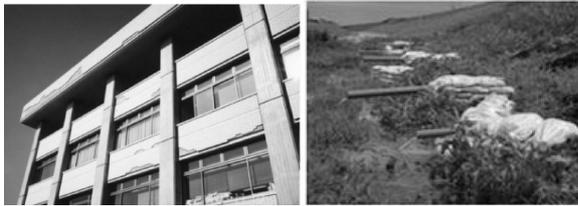
外壁の剥落 河川堤防の漏水
