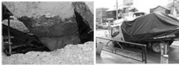
鋼トラス部材の埋込部の破断 埋設管破損による道路陥没
