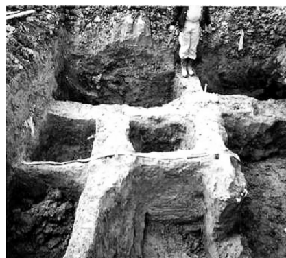
写真－9 格子状改良体
