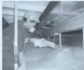
図 4 リフォーム工事の例 (天井の断熱改修)
