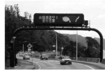
道路情報設備
