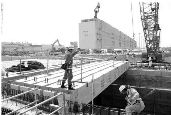
写真-4 1期アンダーパス PC 桁仮設
