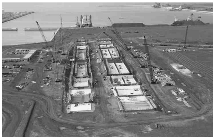
写真一 3 2期アンダーパス
