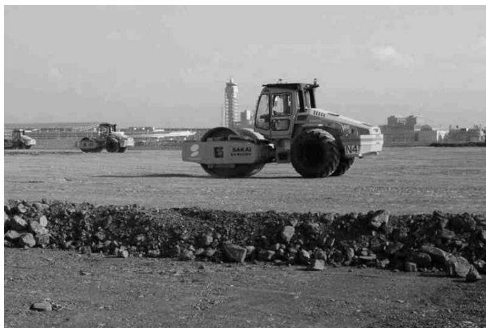
写真一 2 振動ローラーによる転圧作業
