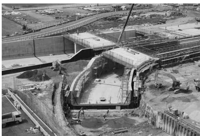
写真-5 1期アンダーパス PC 蓋掛け構造
