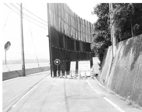
写真 4 実例④（飛散防止材：金網，シート）
