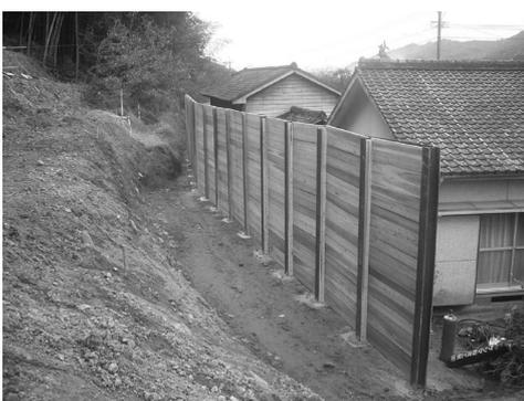
写真 2 実例②（土留材：板材）
