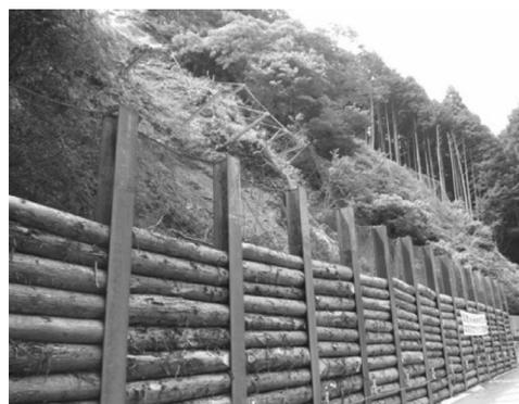
写真 3 実例③（土留材：丸太材）
