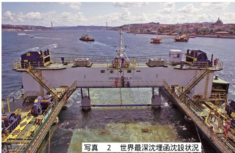
写真 2 世界最深沈埋函沈設状況
