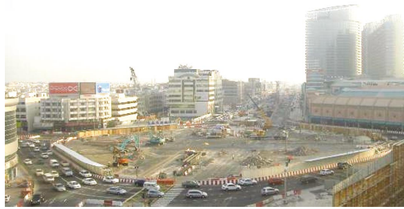
写真 2 道路切り回し工事状況
