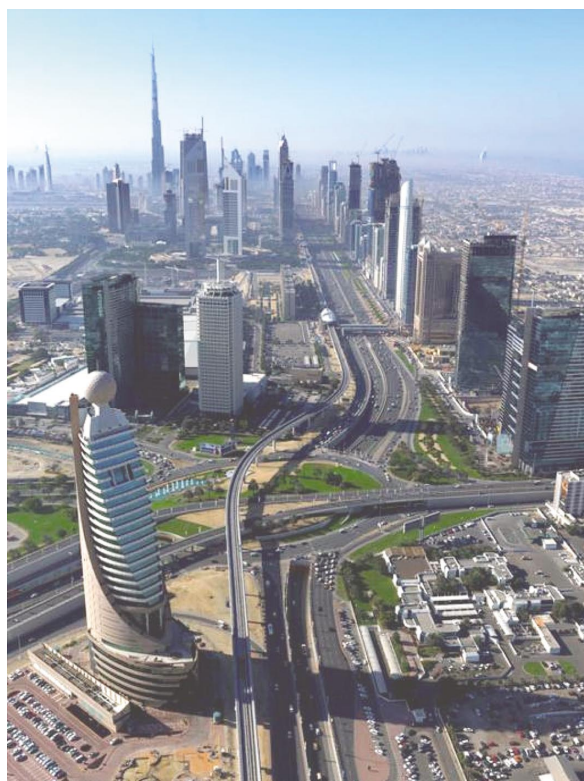
写真 1 超高層ビル街を走るメトロ高架橋
