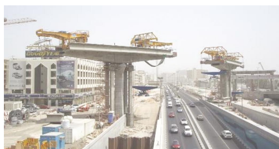
写真 3 高架橋架設状況（3径間連続橋）
