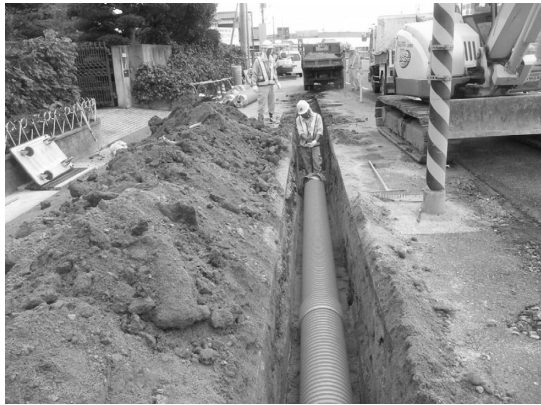
写真 5 管路工（本体管 合成樹脂製）
