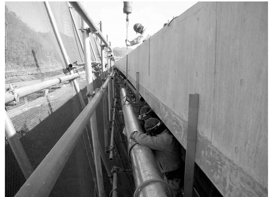
写真 7 管路工（本体管設置 鋼製）
