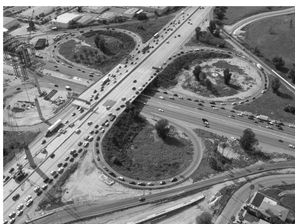
写真-11 工事着工時のクローバーリーフ（交通渋滞のピークを過ぎた後）
