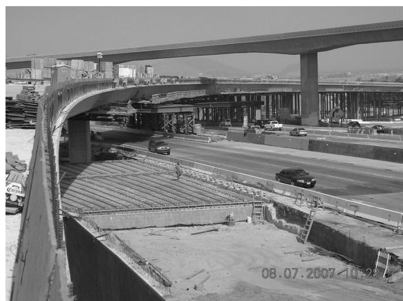
写真-8 施工中の215号南車線から60号線東車線へのバイパス橋梁
