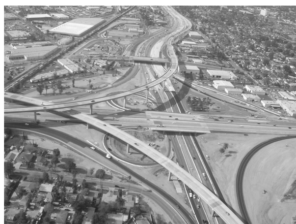
写真-12 バイパス橋梁完成後のクローバーリーフ
