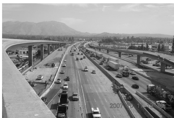
写真-9 215号北車線から91号線西車線へのバイパス橋梁から見る215号と60号線
