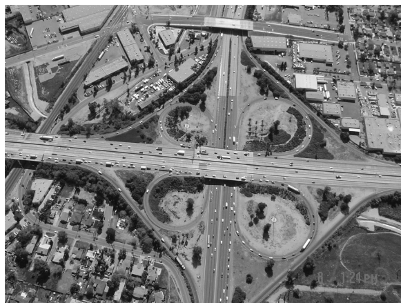
写真-10 工事着工前のクローバーリーフ（午後1時過ぎ）
