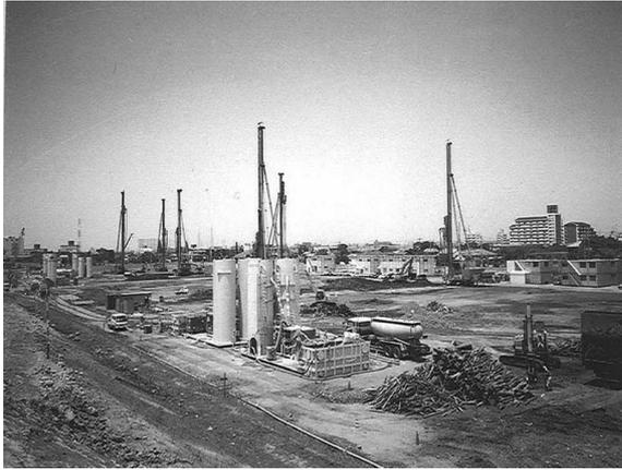
写真 1 地盤改良施工状況
