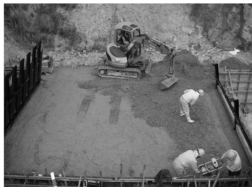
写真－3 敷均し・締固め
