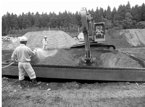
写真－2 攪拌混合
