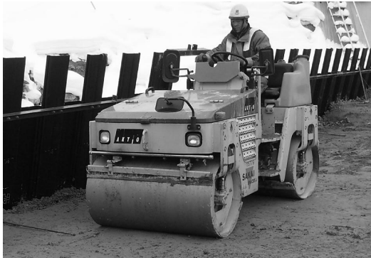
写真－4 振動ローラによる締固め
