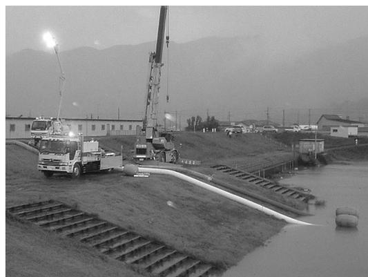
写真 7 排水ポンプ車設置状況
