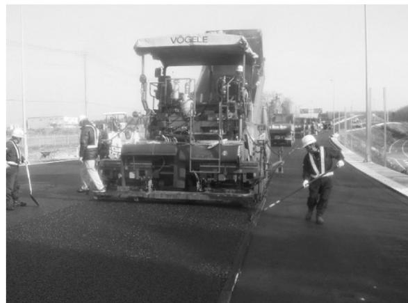
写真 2 アスファルト混合物の敷均し状況
