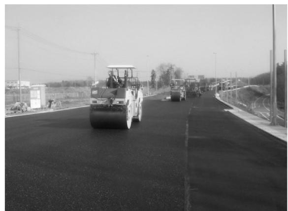
写真 3 アスファルト混合物の転圧状況
