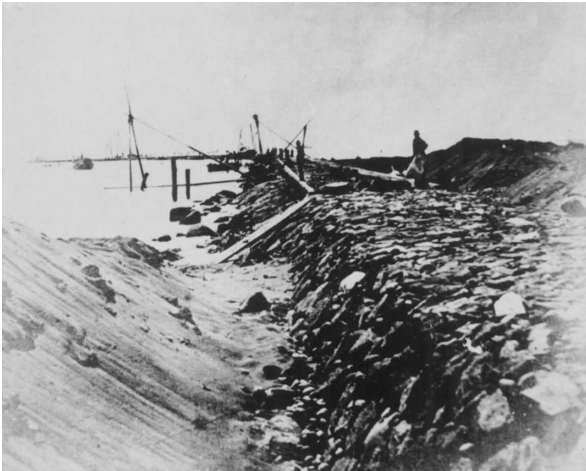
写真 1 築堤作業の様子
