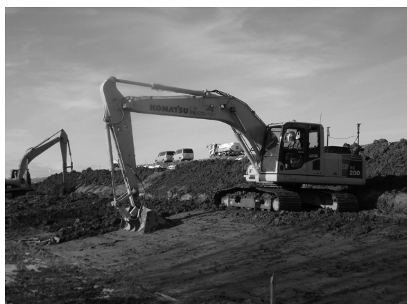
写真－1 バックホウによる情報化施工
