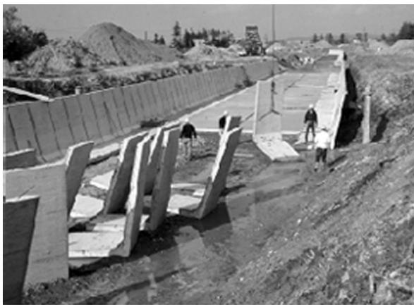
写真 4 昭和43年頃L型ブロック工法(奈井江町) 左
