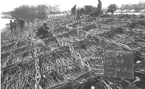
写真－3 粗朶沈床
