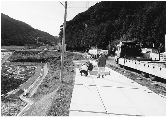
写真 1 組立歩道の形式 (プレキャスト床版支柱式)
