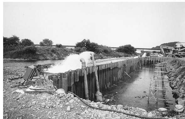
写真 締切排水状況
