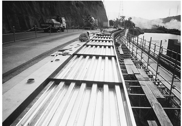
写真 2 組立歩道の形式 (現場打コンクリート床版支柱式)
