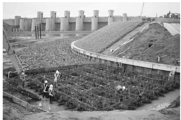
粗朶沈床(新潟県信濃川洗堰)
