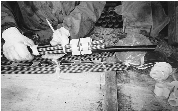
写真－3 アンカー鋼材組立・加工状況
