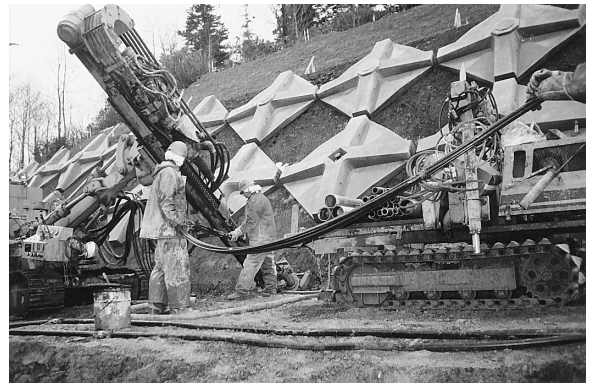
写真-2 削孔機械（クローラタイプ）
