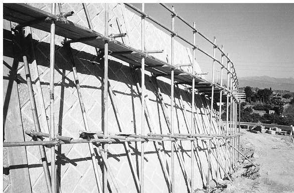
写真－3 単管傾斜足場設置状況
