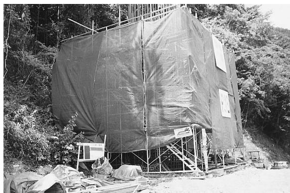
写真－4 安全ネット設置状況
