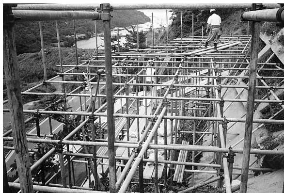
写真－2 単管足場設置状況
