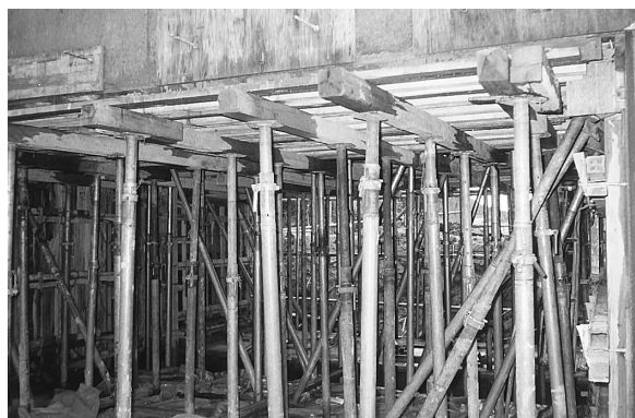
写真－5 パイプサポート支保設置状況
