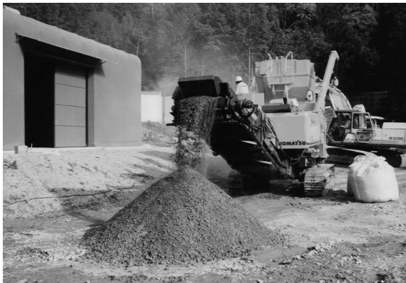
写真 1 自走式土質改良機による製造
