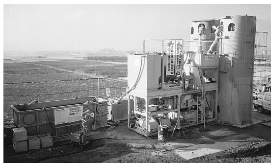
写真-3 改良材供給機設置状況
