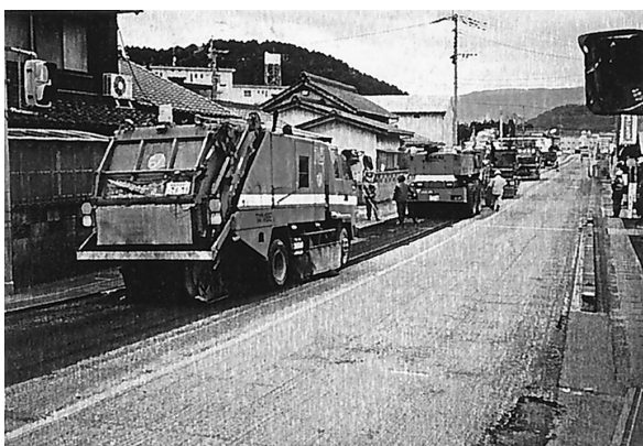
写真－2 施工状況
