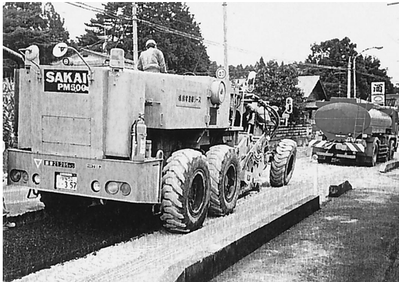
写真－4 不陸整正・敷均し状況
