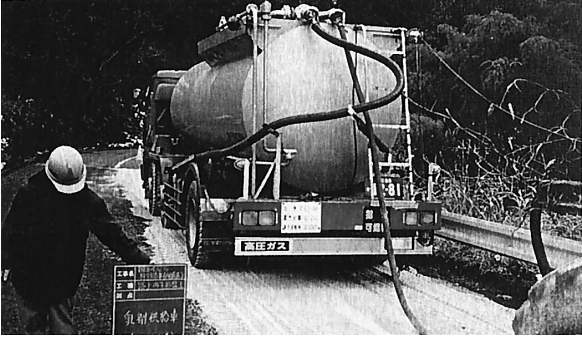
写真－２ 混合用乳剤散布状況
