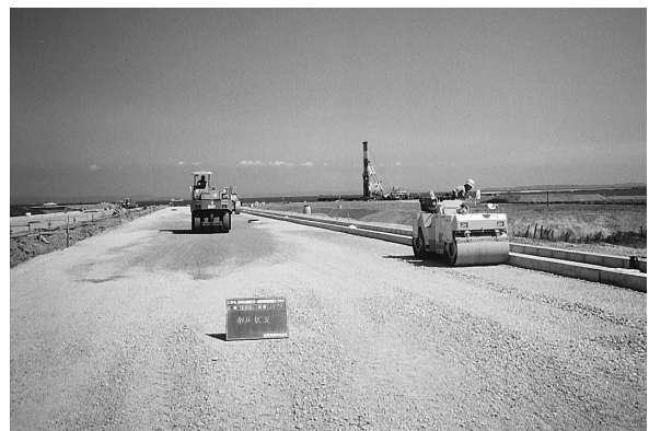
写真－3 締固め作業状況
