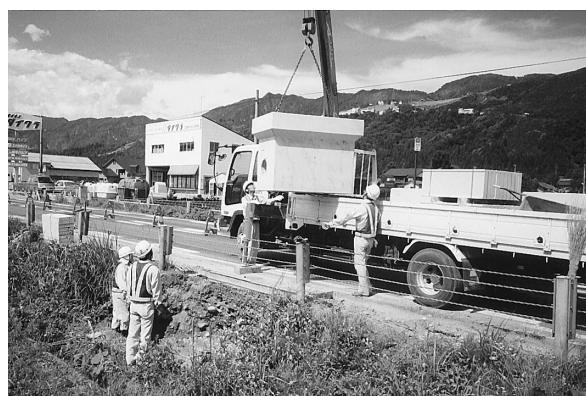
写真－２ ハンドホール設置作業状況
