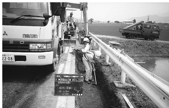
写真－１ バックホウ掘削作業状況
