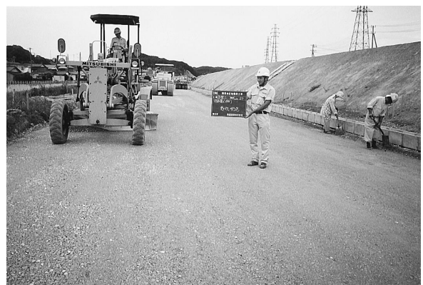
写真－3 締固め作業状況
