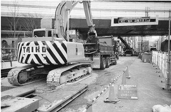
写真－2 バックホウ掘削作業状況
