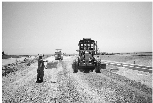
写真－2 敷均し作業状況
