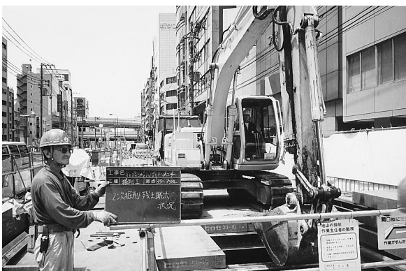
写真－2 バックホウ掘削作業状況
