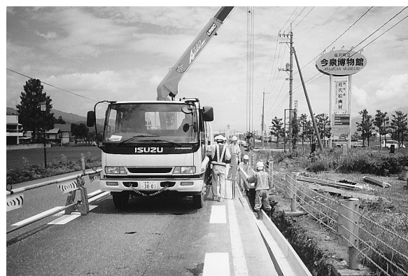
写真－４ 管路材（さや管）設置作業状況
