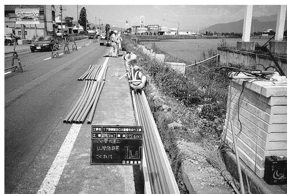
写真－４ 管路材（さや管）設置作業状況
