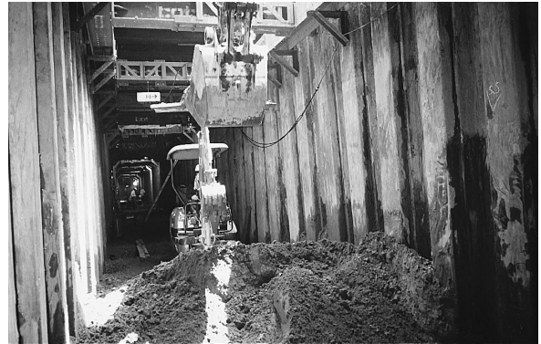
写真－3 小型バックホウ集土作業状況
